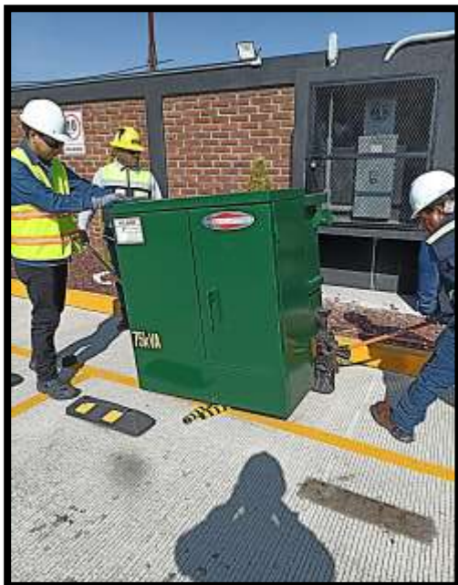
Venta e instalación de transformadores
